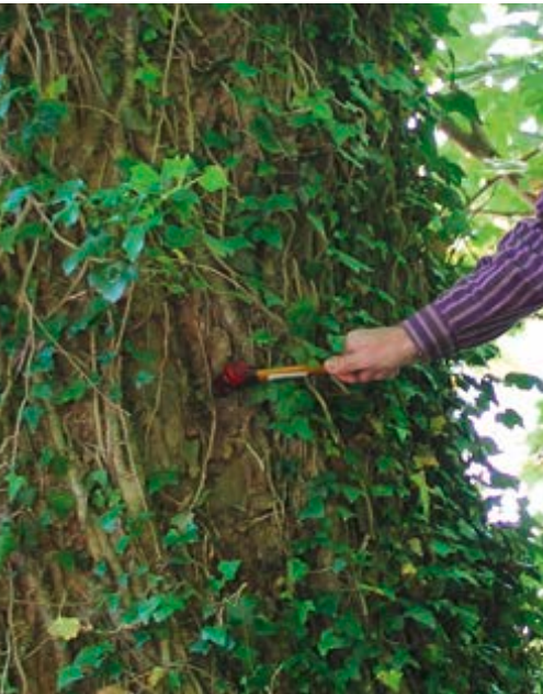
Bild 19: Kontrolle einer möglichen Faulstelle mit dem Sondierstab
