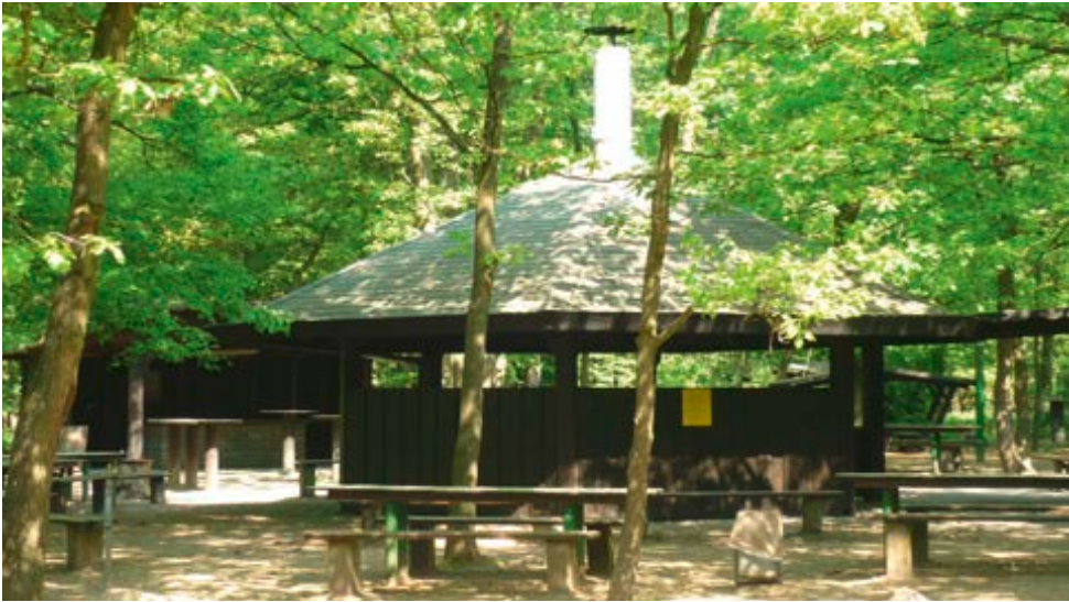
Bild 16: Bei Erholungseinrichtungen im Wald muss der Bestand bis zu einer Entfernung von einer Baumlänge vom äußeren Rand der Einrichtung einer regelmäßigen Baumkontrolle unterzogen werden. Auch die technische und bauliche Sicherheit der Einrichtung muss regelmäßig überprüft werden.
