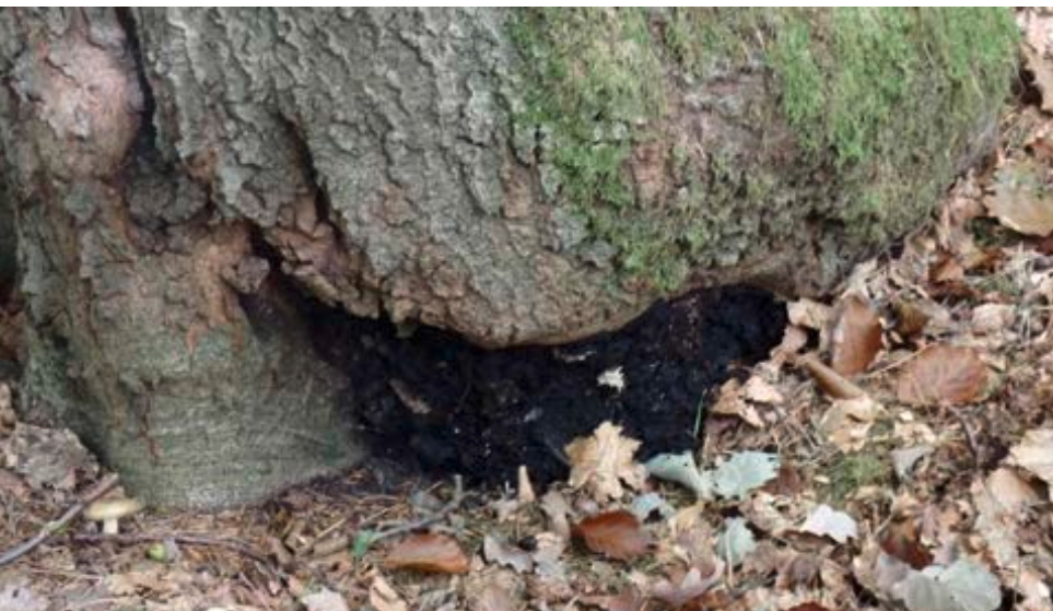
Bild 23: Beispiel eines gefährlichen Pilzbefalls: „Unauffälliges“ Erscheinungsbild des Brandkrustpilzes im Bereich der Wurzelanläufe einer Buche. Der Brandkrustpilz zerstört an Laubbäumen das Holz oft von innen nach außen und führt zu Spröbruch bei noch „gesundem“ Erscheinungsbild des Baumes.
